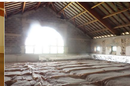
Premier étage de la piscine
